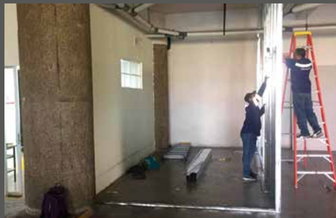
Febrero 2019. Construcción de Cubículos de Consulta
