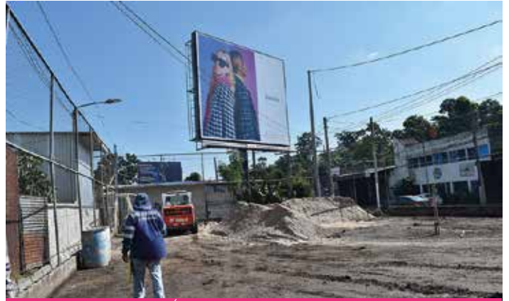
COLOCACIÓN DE CONCRETO EN CANCHA DE COMUNIDAD EL TANQUE
