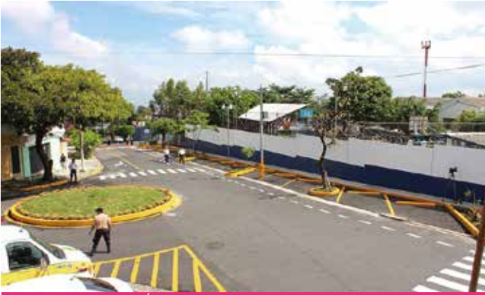
AMPLIACIÓN DE ESTACIONAMIENTO VEHICULAR 3º AVENIDA NORTE
