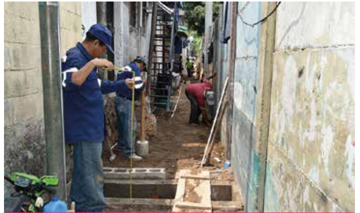
CAMBIO DE TUBERÍA DE AGUA LLUVIA EN PJE. PRINCIPAL DE COMUNIDAD ALEMANA
