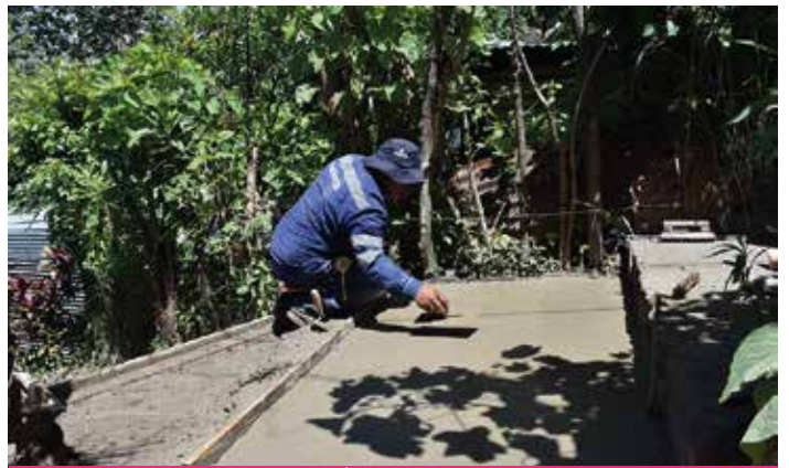
CONSTRUCCIÓN DE 54 ml DE ACERA EN COMUNIDAD EL TANQUE
