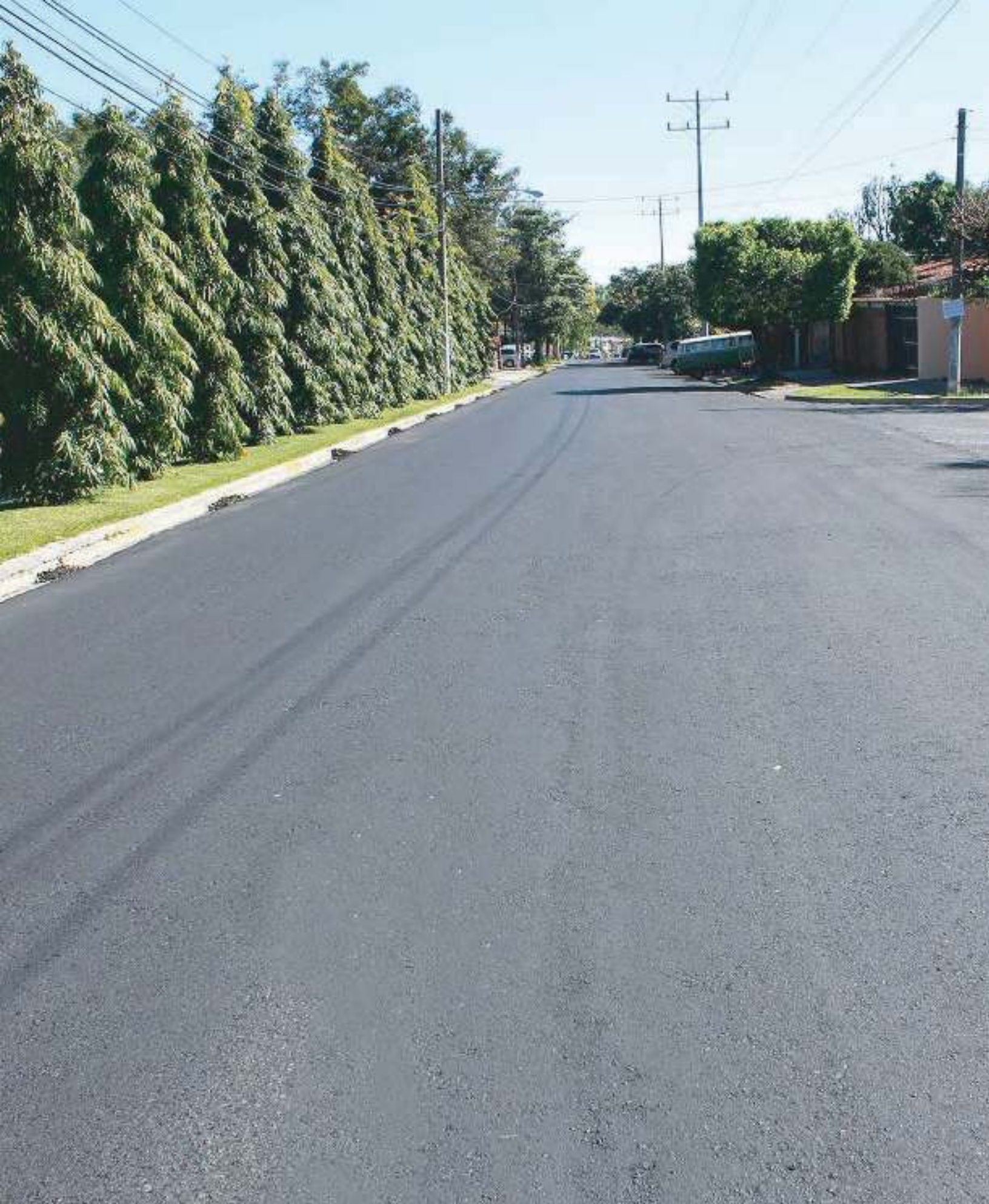
Recarpeteo en Calle Antiguo Ferrocarril, Urbanización La Sultana I Etapa
